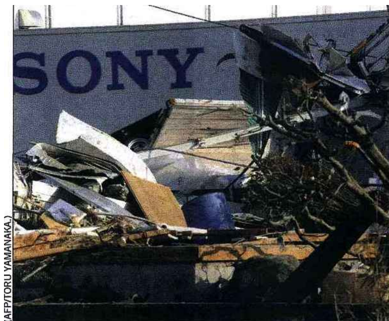
A la suite du tremblement de terre et du tsunami, de nombreuses usines japonaises de composants ont été détruites ou privées d'électricité.
